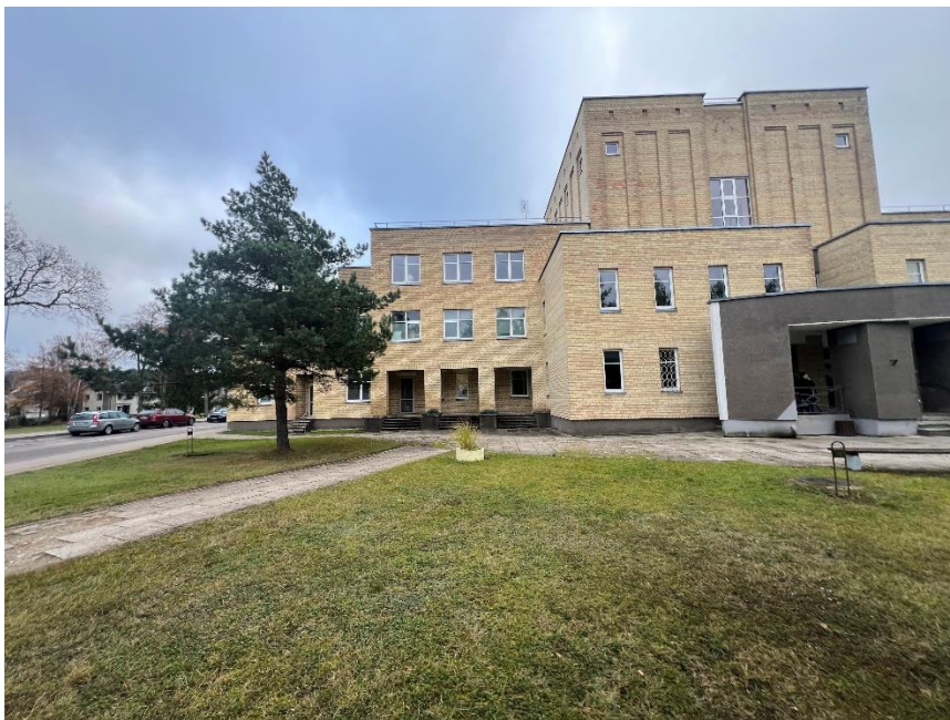
Fotofiksacija pv.1 būklės įvertinimui.
