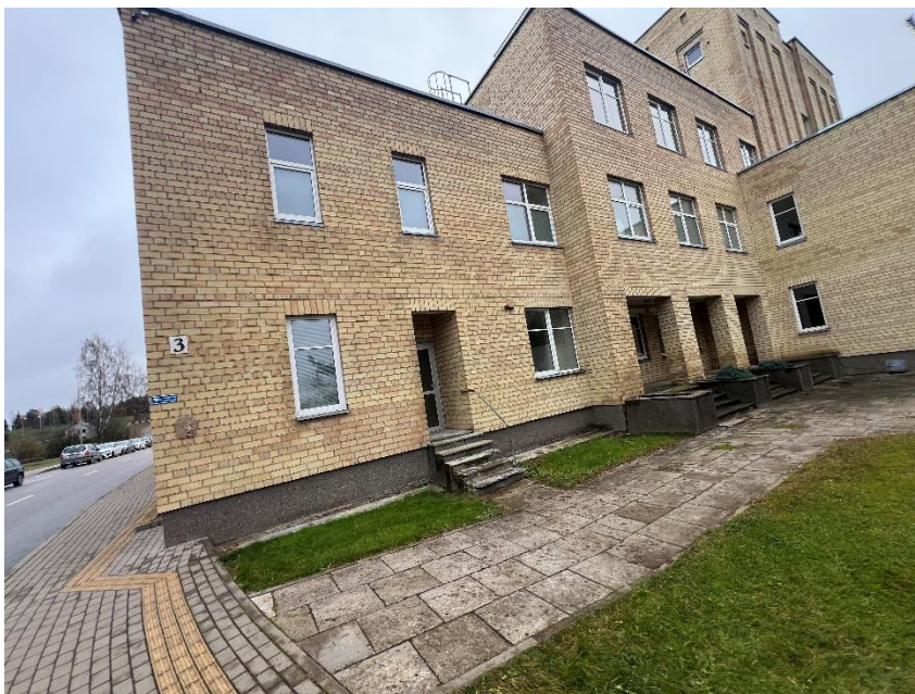
Fotofiksacija pv.2 būklės įvertinimui.
